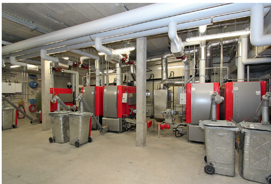
Rechts: 1-Meter- und ½-Meter-Stückholzheizungen im neuen Corporate Design. Unten: 1200-kW-Heizzentrale Beringen.
