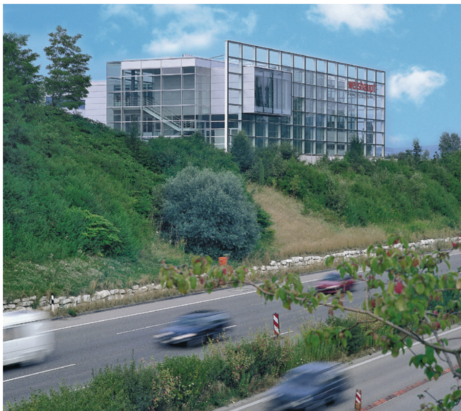
Das Verwaltungs- und Schulungszentrum in Geroldswil – direkt an der Autobahn – ist ein Kompetenzzentrum zur Aus- und Weiterbildung von Fachleuten. (Bilder: zVg)
