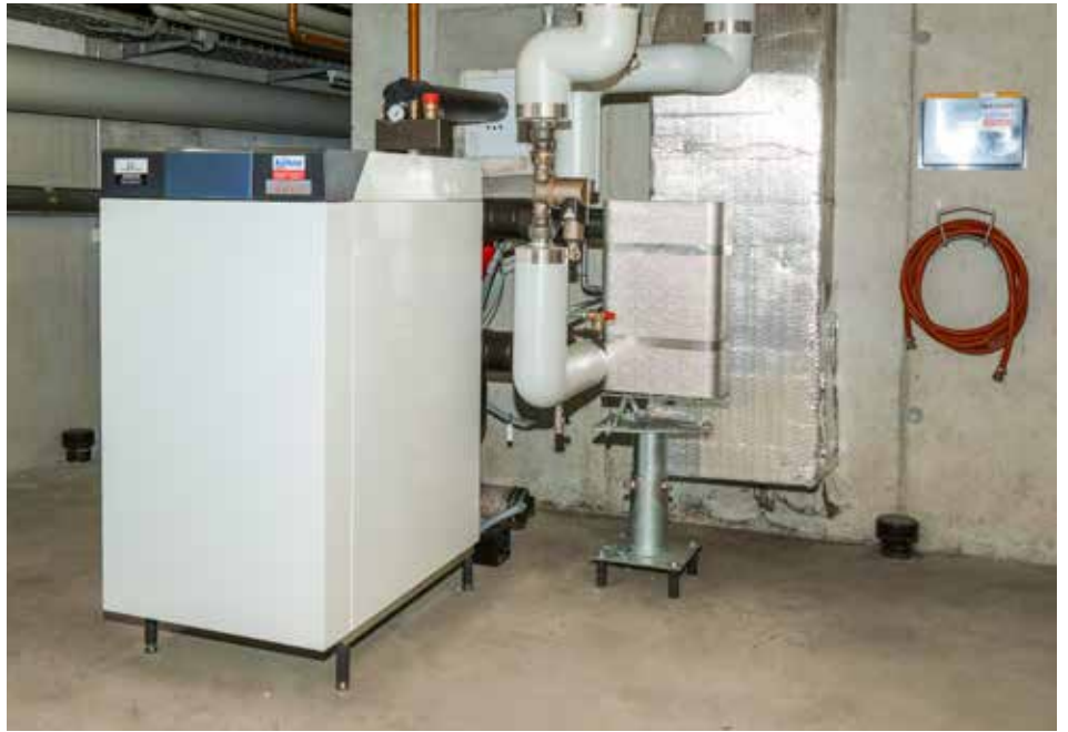
Der Weishaupt WTC GB 170 Gas-Brennwertkessel.
