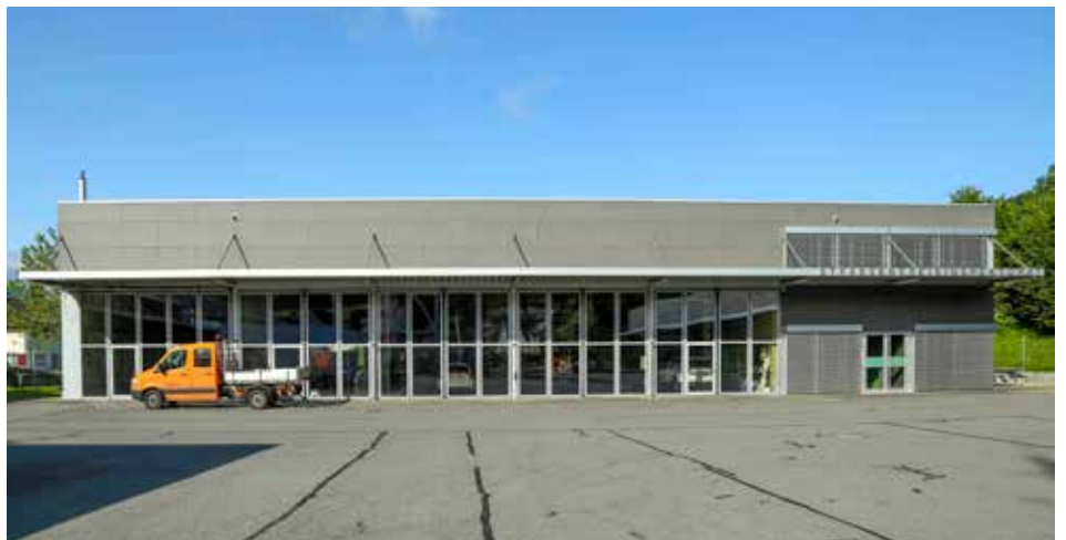
Teilansicht des Strassenkreisinspektorats Schmerikon.
