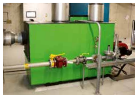
Anhand des digitalen Feuerungsmanagers lässt sich die Leistung des Monarch-Zweistoffbrenners ohne Weiteres auch auf einen neuen Kessel einstellen oder einregulieren, sollte ein Austausch dieser Komponente einmal zum Thema werden.
