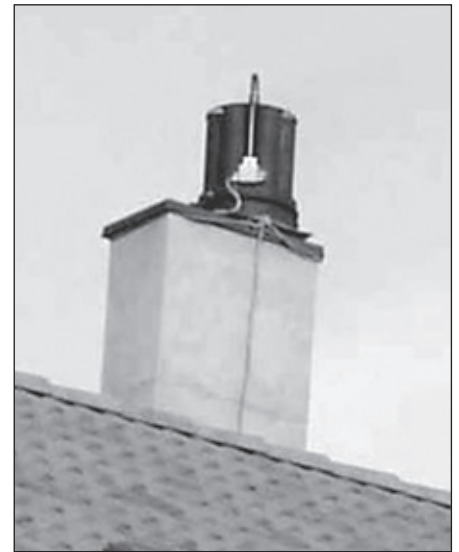
Bild 4: Prototyp eines elektrostatischen Feinstaubabscheiders zum Aufbau auf den Kamin (Bilder: M. Berntsen, Norwegen).
